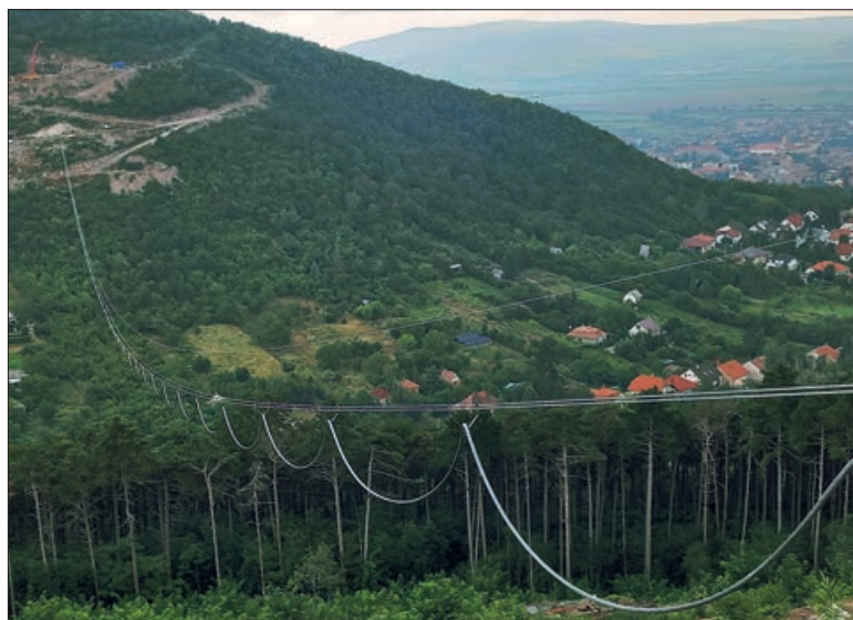
8. ábra: Főkábel áthúzása
