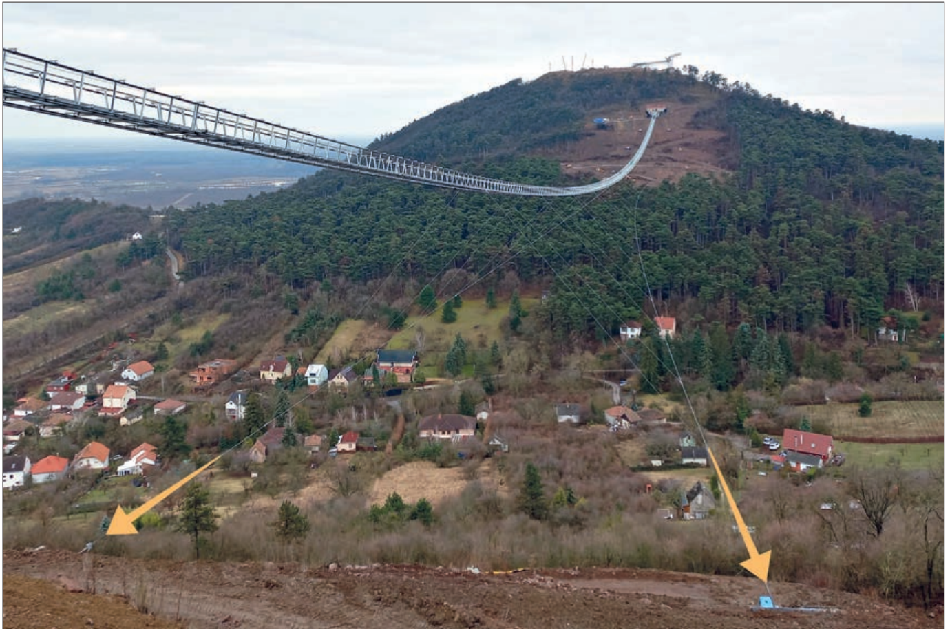
21. ábra: Szélkábelrendszer kifeszítése
