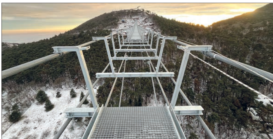
17. ábra: Már csak a hídközépi üvegelemeket fogadó pályatáblák hiányoznak
