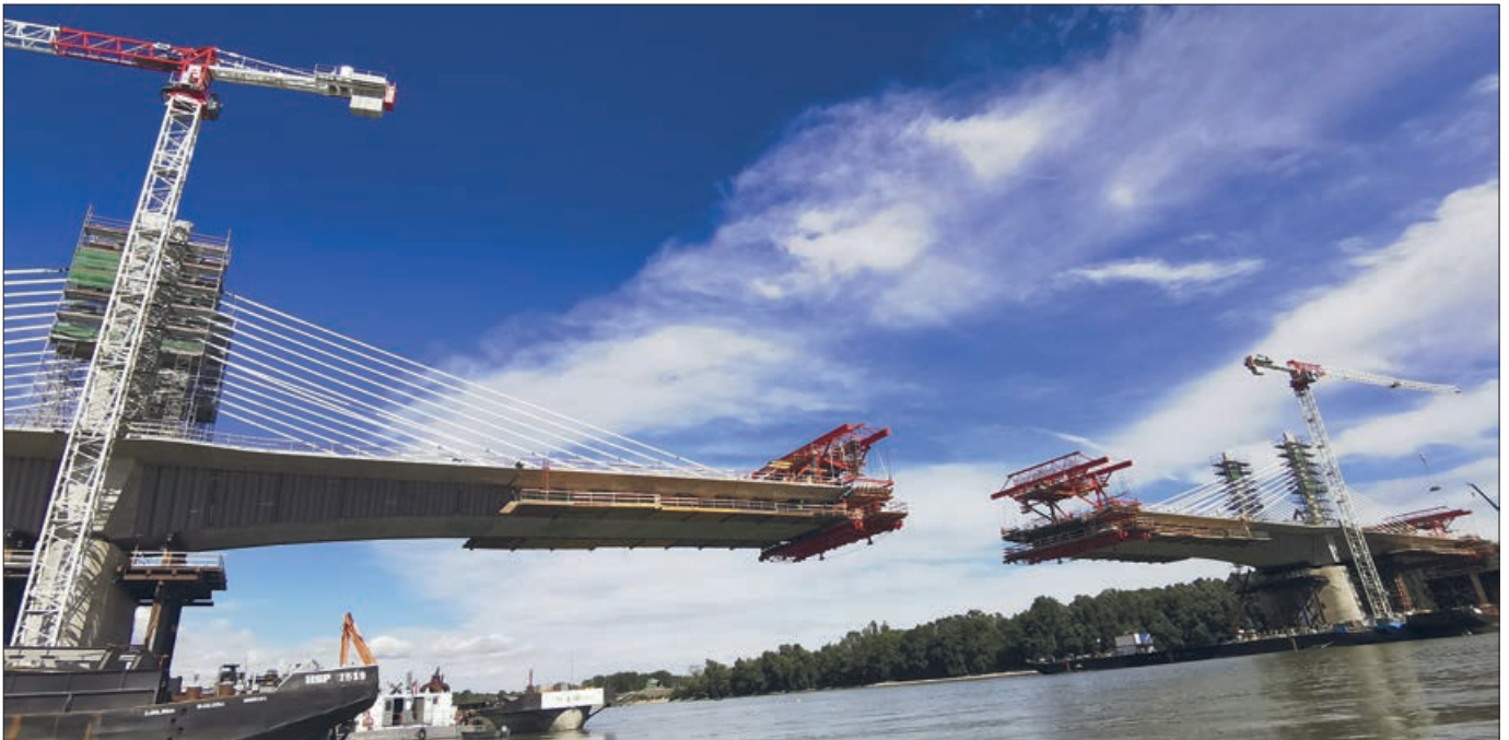
6. ábra: Medernyílás, építési állapot
