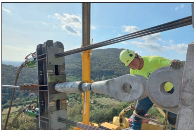
11. ábra: Főkábelbekötés a szárhegyi hídfőbe
