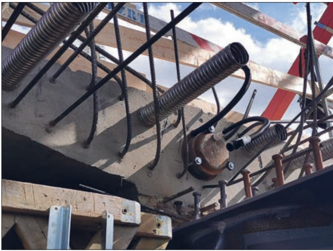
5. ábra: Pályalemez feszítőkábel lehorgonyzása
