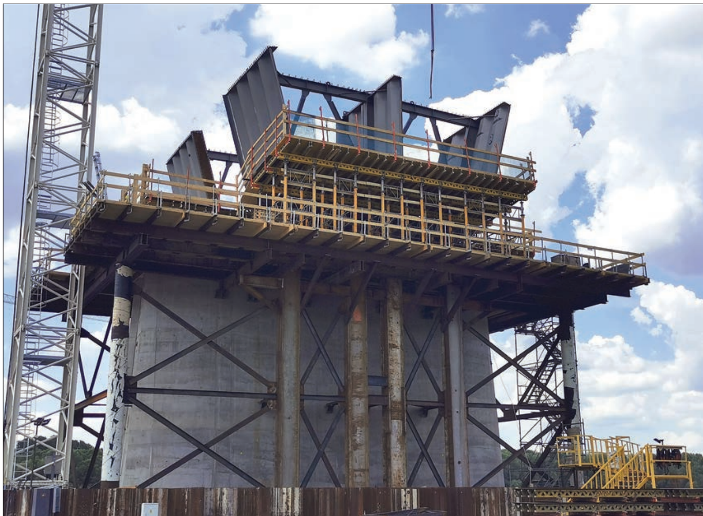
2. ábra: Mederpillér/indítóállvány és 1-es zömök
