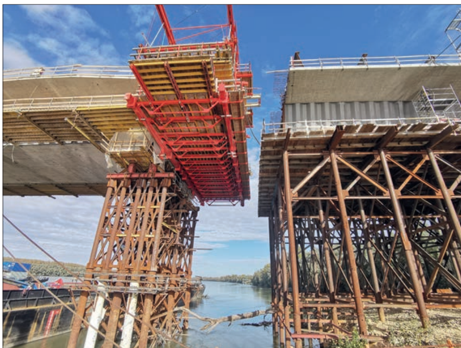
4. ábra: SJ2 segédjárom és betonozóállvány a közös pillér előtt
