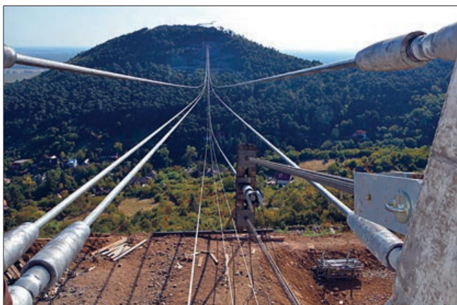
9. ábra: Főkábelbekötés hídtengelyből fotózva
