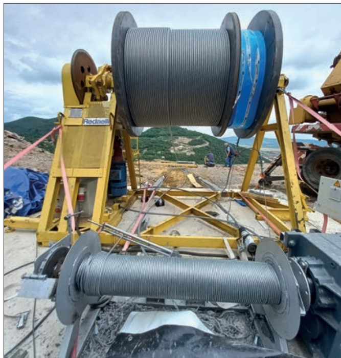
4. ábra: Vontatókötél (alul) és a dobról lefejtett D = 128 mm-es segédkábel
