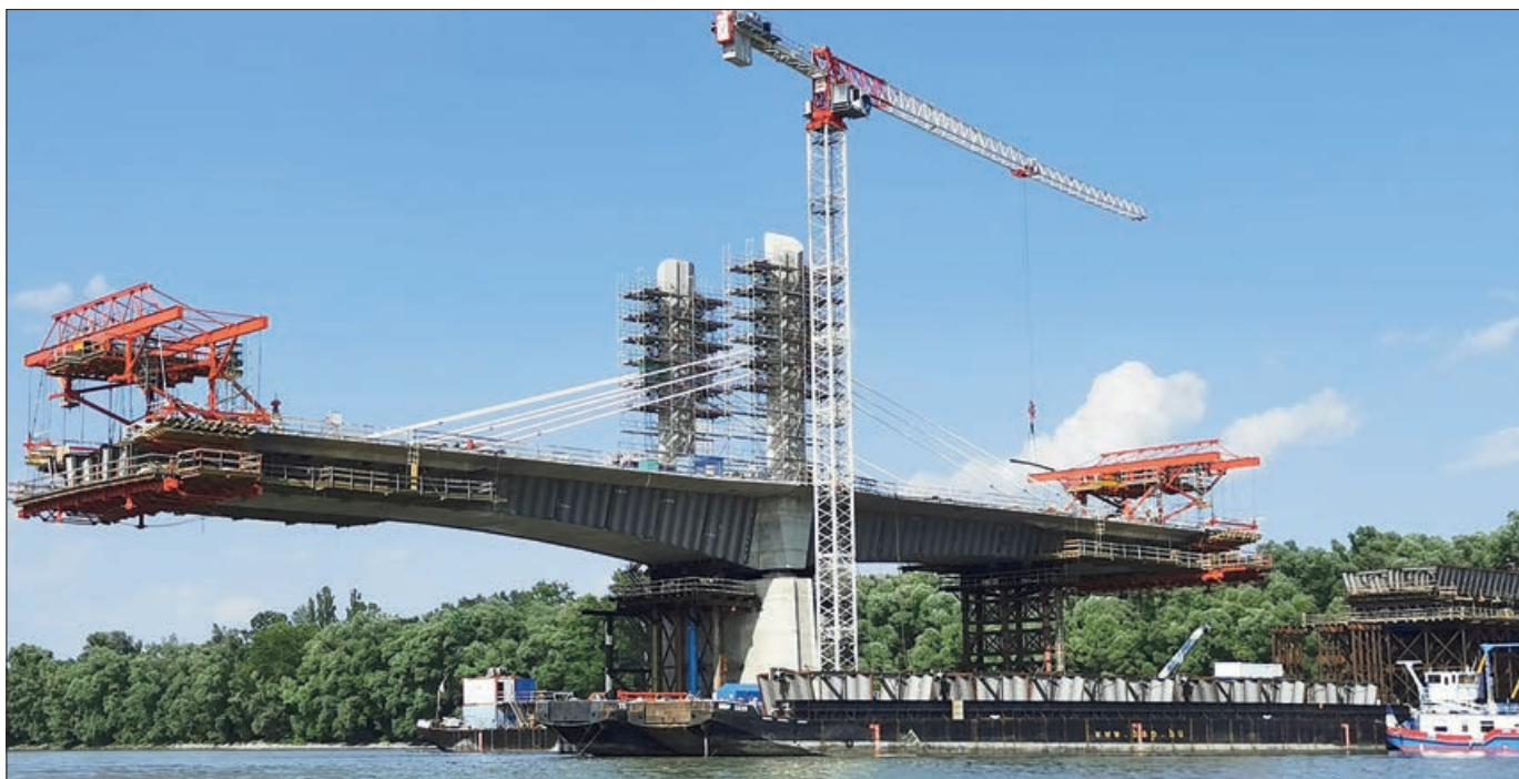
3. ábra: Segédszerkezet a kalocsai oldalon
