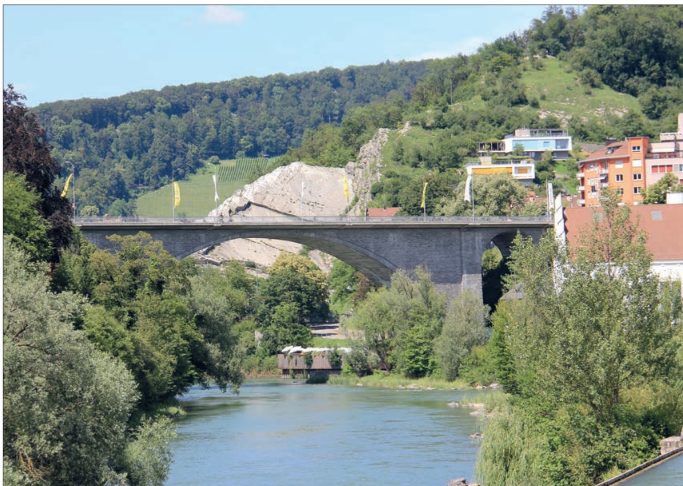
14. kép: Baden, Limmat Hochbrücke
