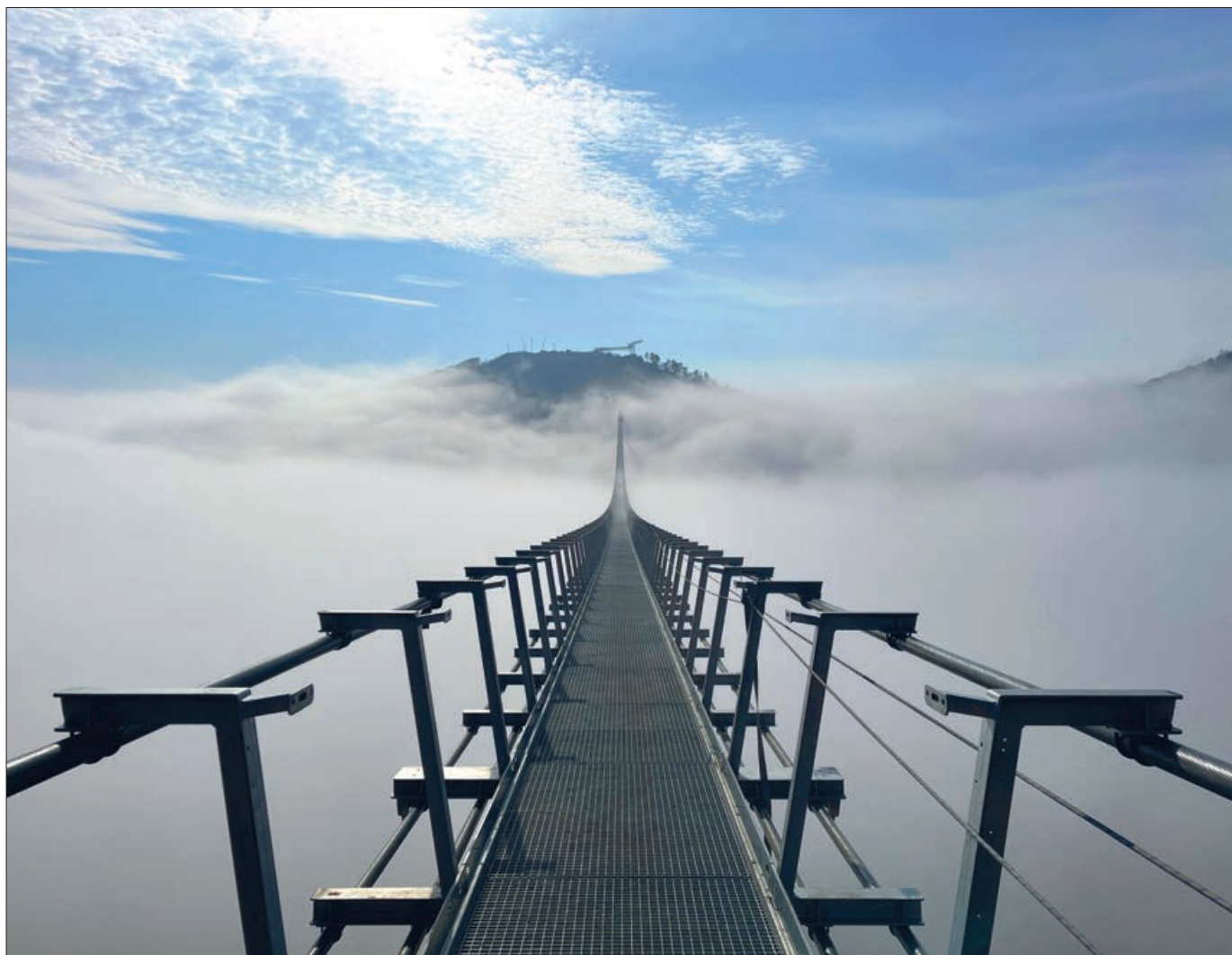
26. ábra: A szerkezetkész híd ködben (pályáról fotózva a Szárhegy felől)
