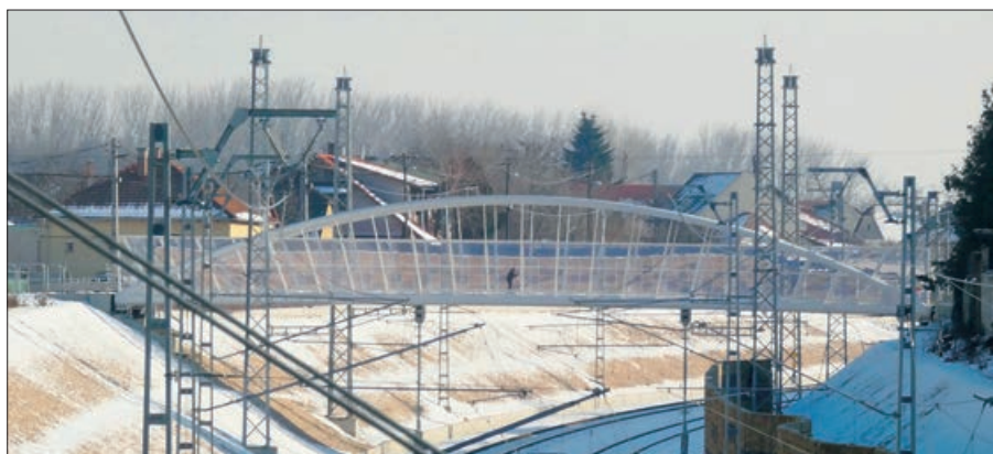
2. ábra: Felcsapódás elleni érintésvédelem – hagyományos és innovatív megoldás
