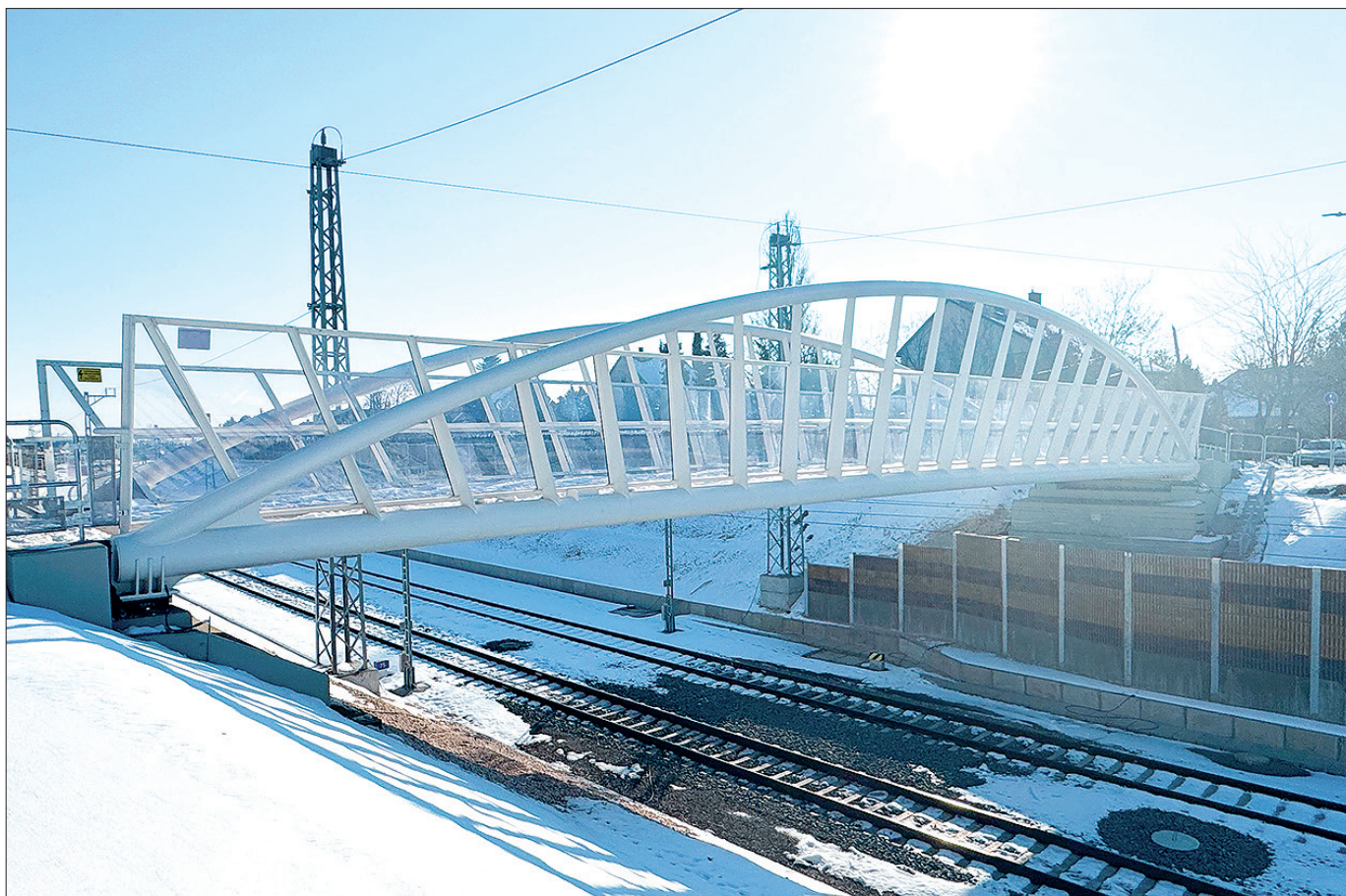
19. ábra: A Török utcai híd
