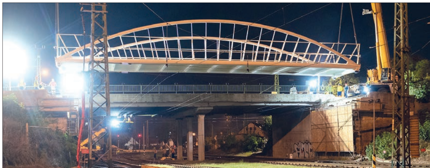
10. ábra: A Kisfaludy utcai híd beemelése
