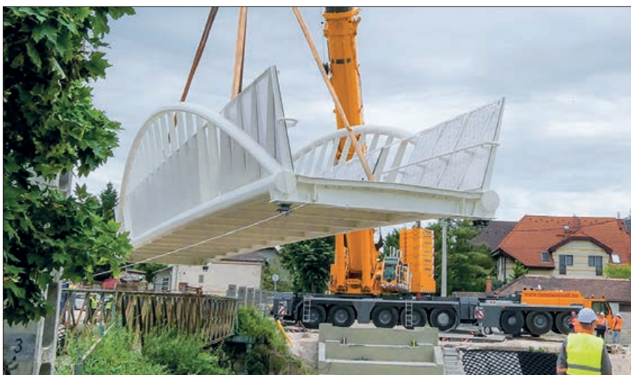
12. ábra: A Török utcai híd beemelése
