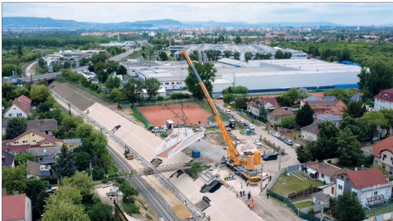
13. ábra: A Török utcai híd beemelése
