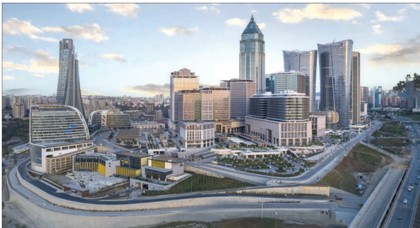
18. kép: A Török Köztársaság Központi Bankjának épülete, forrás: https://www.skyscrapercenter.com/building/central-bank-of-the-republic-of-turkiye/4114
