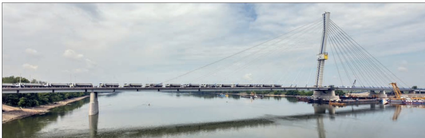
2. ábra: Monostori híd Magyarország és Szlovákia között a próbaterhelés idején [17]
