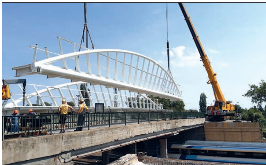
8. ábra: A Kisfaludy utcai híd építése
