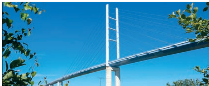
4. ábra: Rügeni híd, Németország [3]
