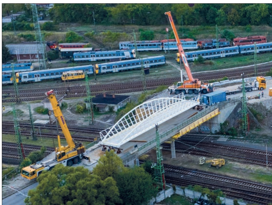
9. ábra: A Kisfaludy utcai híd beemelése
