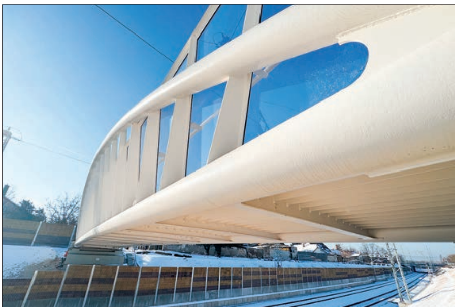
18. ábra: A Török utcai híd
