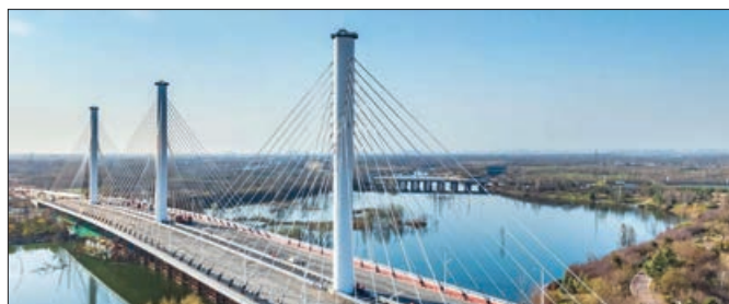
3. ábra: Fengyi híd, Kína [2]
