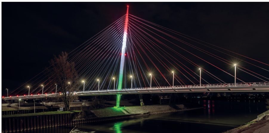
3. ábra: Híd díszvilágításban (Magyar Építők)
