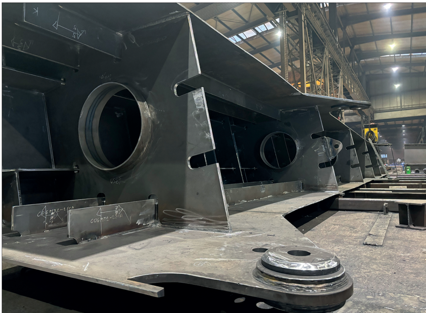
8. ábra: Merevítőtartó kábelfogadó füllel záródobozolás előtt
