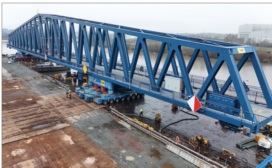
18. ábra: Szállítás közben a forgóegység
