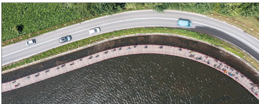
20. ábra: A dániai Hvidkilde tó felett épült gyaloghíd
