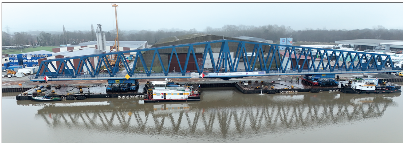
17. ábra: Két uszályra moztatják a forgó hídegységet
