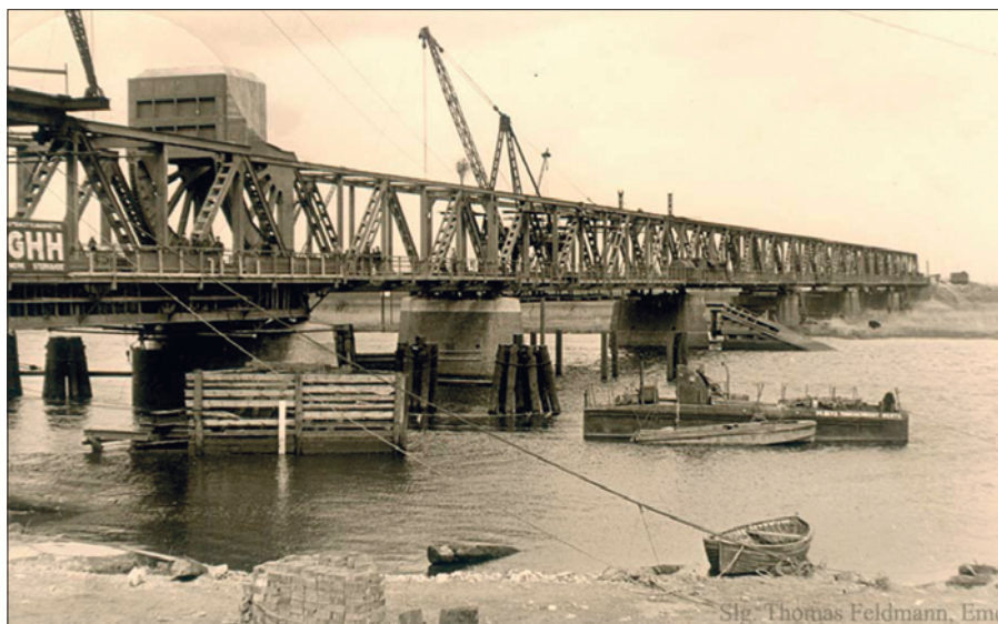
5. ábra: A második Friesenbrücke építése 1926-ban
