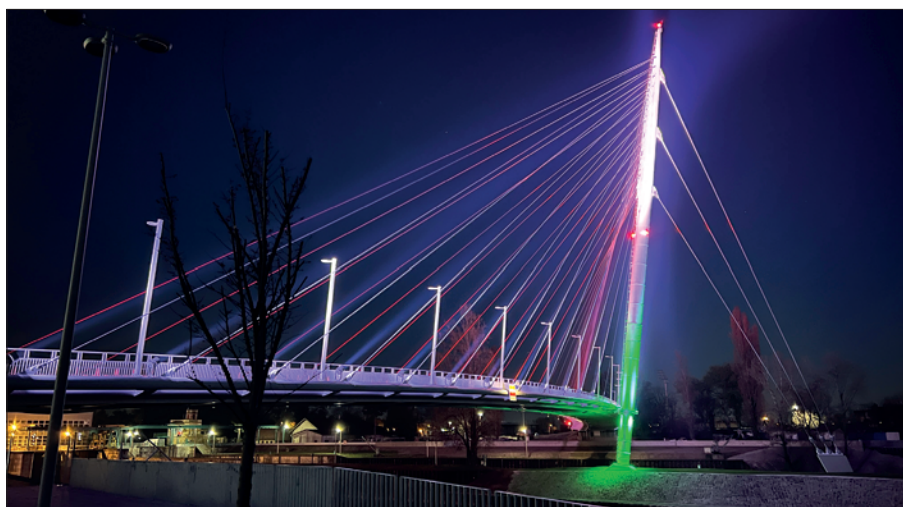
2. ábra: Az ívelt pályát 50 darab kábel tartja (SPECIÁLTERV)
