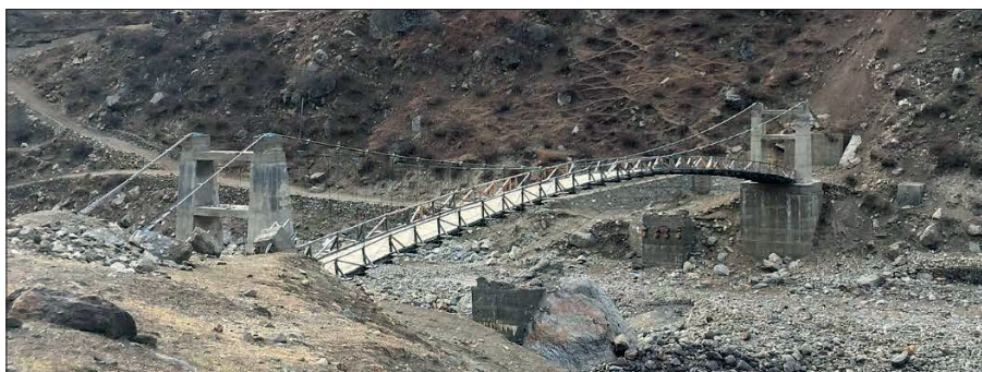
5. ábra: Gyalogos függőhíd a pakisztáni Kunhar folyó felett egy korábbi konzolos fahíd felhagyott hídfői mellett
