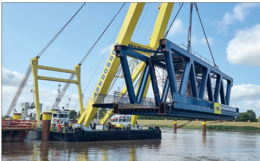
15. ábra: Úszódarun történő szállítás
