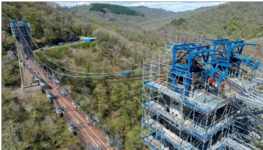
27. ábra: A Rochers Noirs viadukt felújítása
