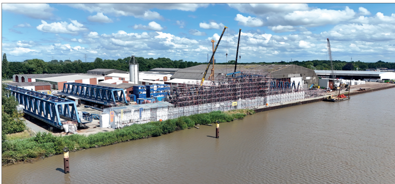
14. ábra: A készülő forgógység a már kész egy- és kétnylású egységgel
