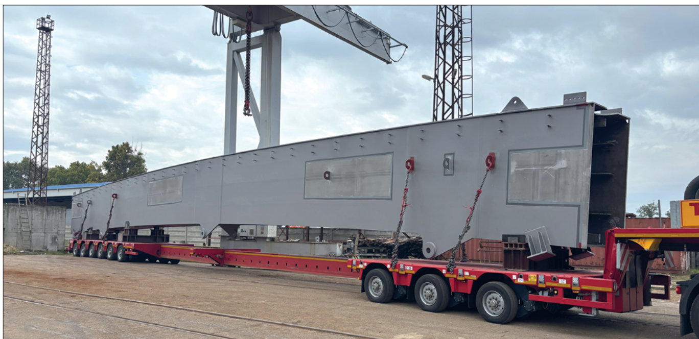
2. ábra: Ívelem szállítása
