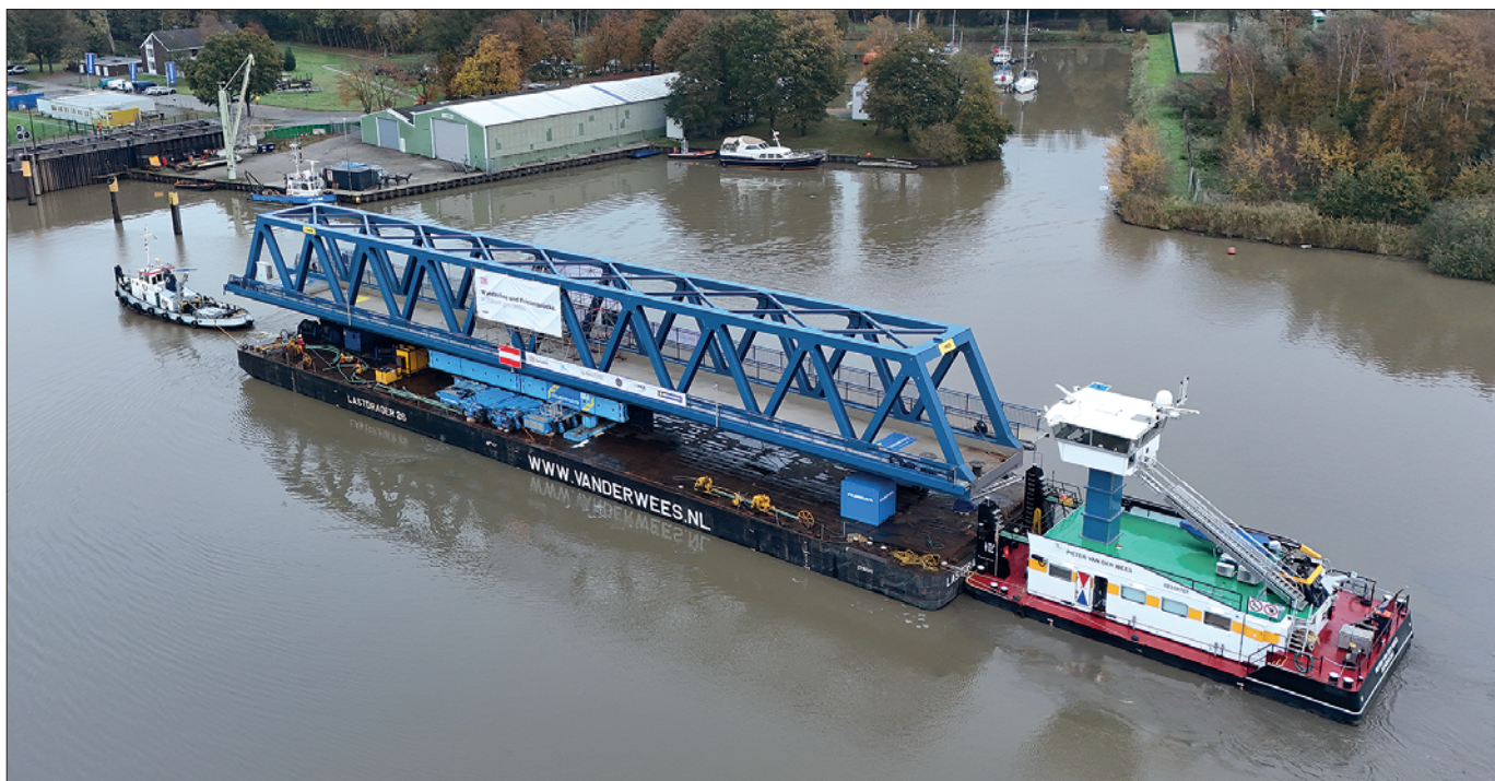
16. ábra: Útközben az egynyílású parti híd
