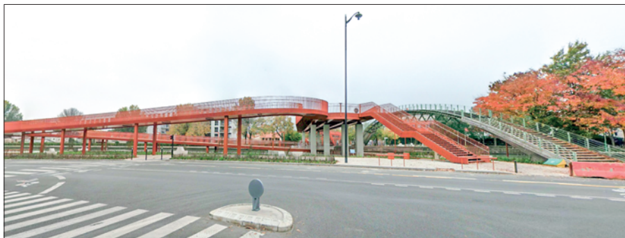
10. ábra: Az újraértelmezett híd oldalról
