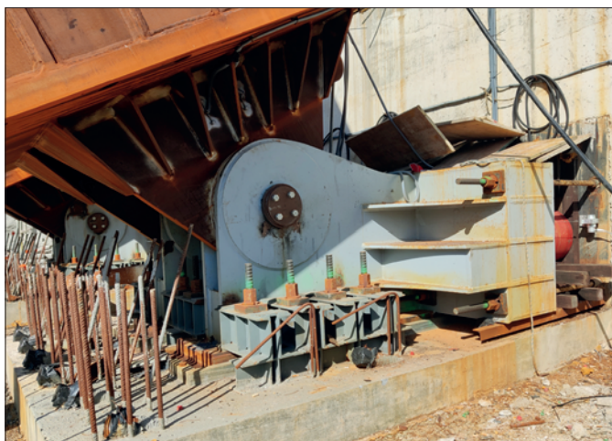
9. kép: Az ívek letámasztásánál kialakított csuklós szerkezet [2]
