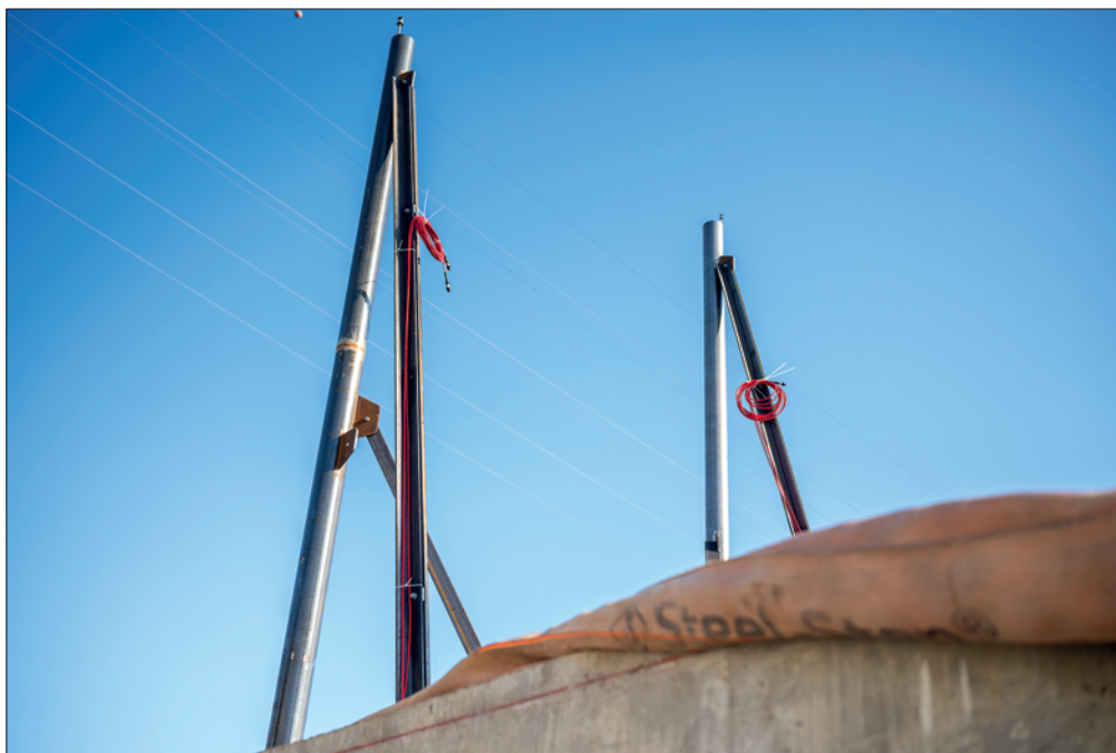
11. ábra: Párosítva szerelt 'A' és 'B' kéregelem és acélmerevítése
