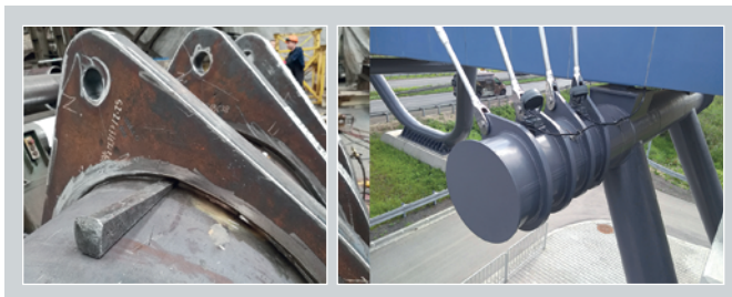
10. ábra: Függesztőkábelek bekötése a kereszttartóba (Glogoczóv)
