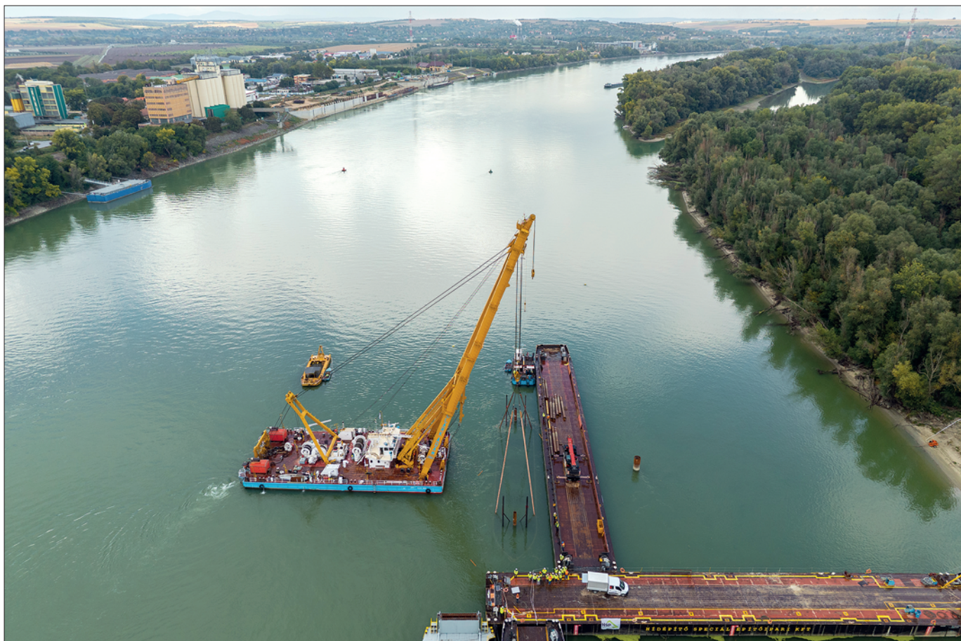
14. ábra: Mohácsi Duna-híd 'A' kéregelem beemelése a Clark Ádám úszódaruval (Fotó: Erdei Mihály, magyarepitok.hu)
