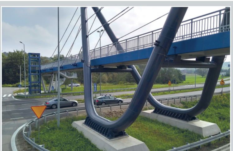
12. ábra: Pálya és cső hossztartó kapcsolata a támaszoknál (bal oldal) és a mélyponton (jobb oldal) (Tisza-híd)
