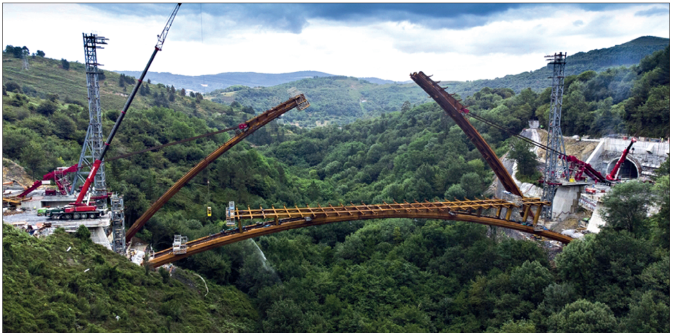
8. kép: A felszerkezet szerelése [2]
