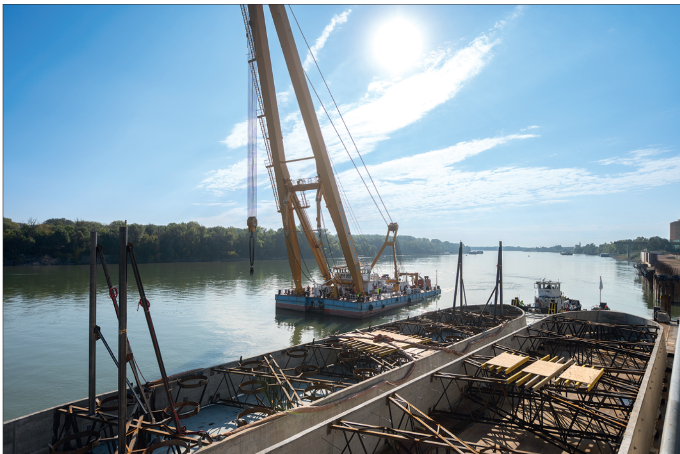
11. ábra: Párosítva szerelt 'A' és 'B' kéregelem és acélmerevítése
