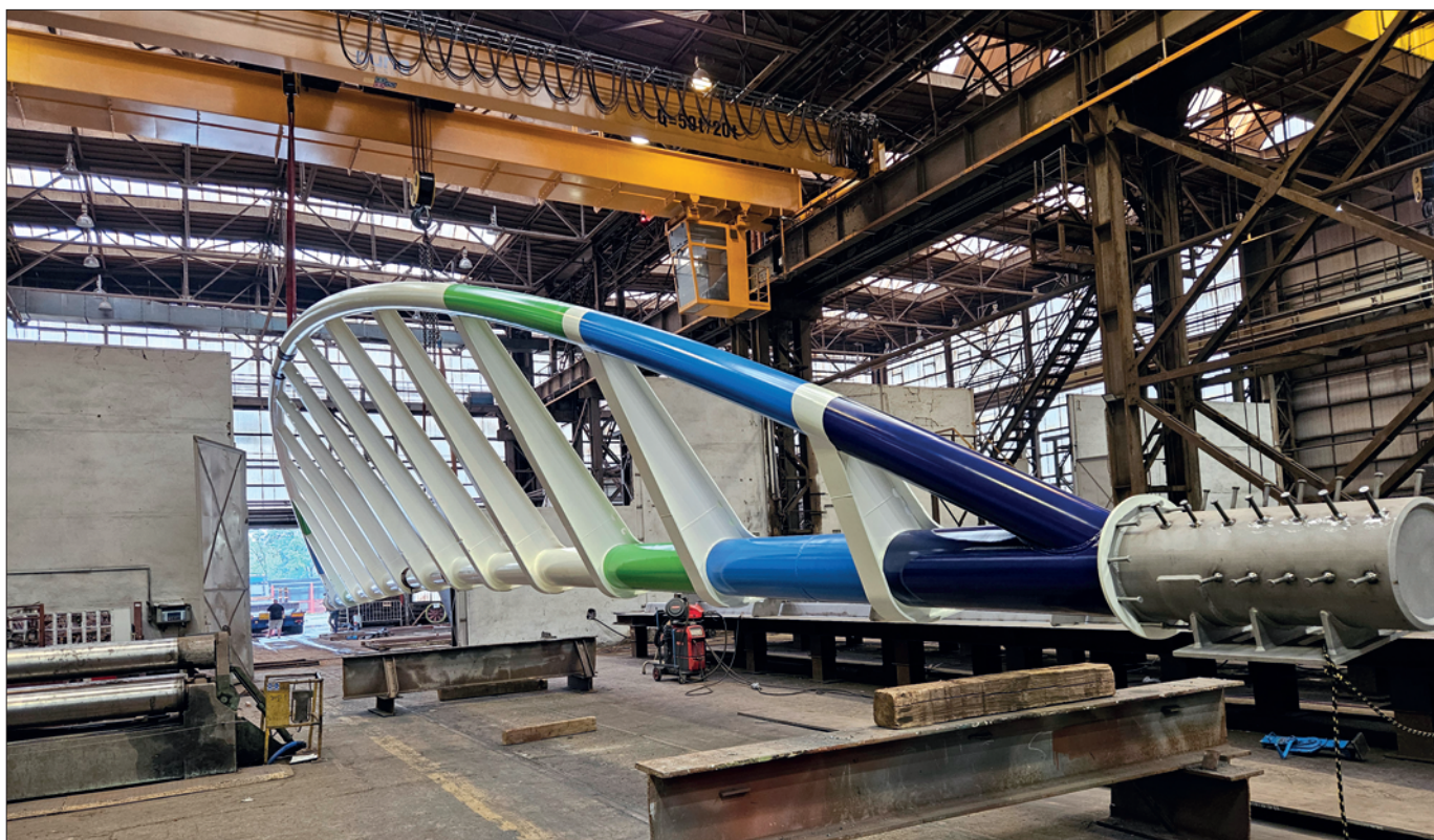
16. ábra: Szczecin – íves tartó kiszállítás
