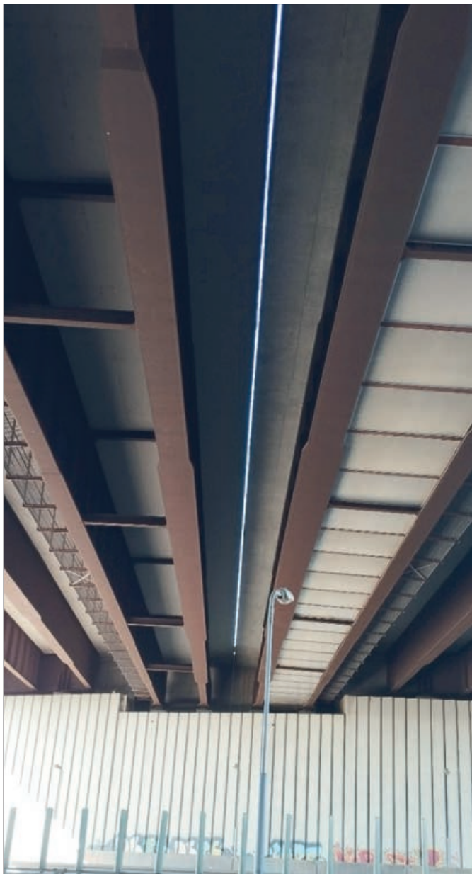
3. kép: Alsóöv-szélesítések az igénybevételnek megfelelően – D1 autópálya feletti híd
