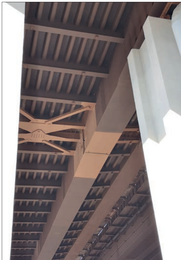
4. kép: A Gerber-tartó közbenső csuklója és az ortotrop acél pályalemez időjárásálló acélból
