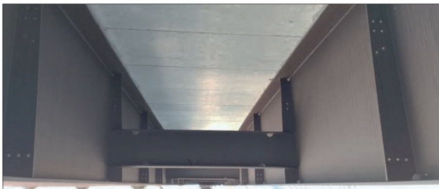
15. kép: Benmaradó kereszttartók a hossztartók között
