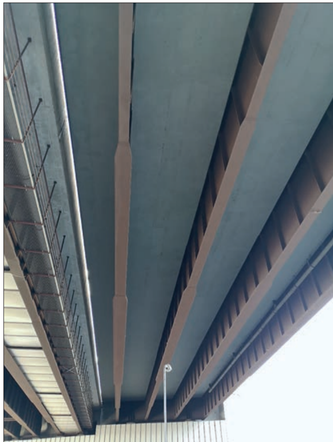
3. kép: Alsóöv-szélesítések az igénybevételnek megfelelően – D1 autópálya feletti híd
