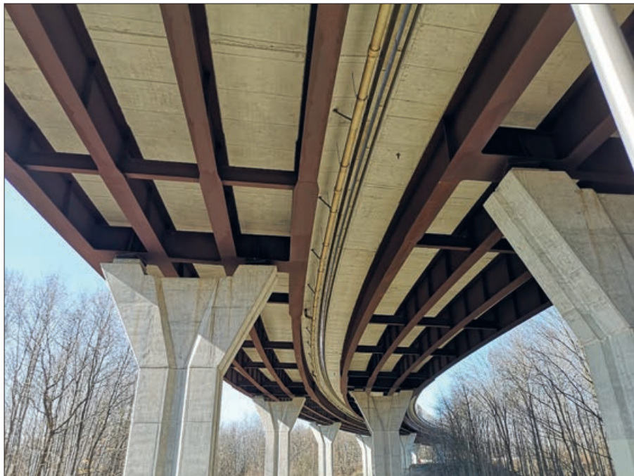
14. kép: Híd alatti tér a keskeny légréssel
