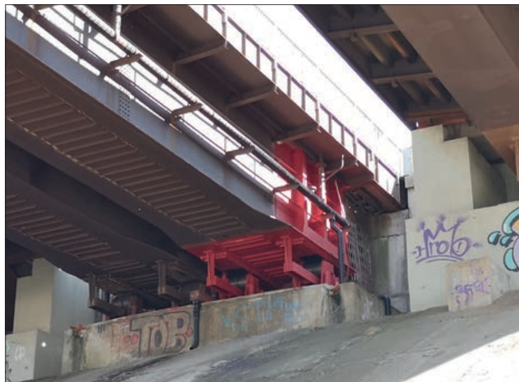
6. kép: Korrózióvédelmi felújítás a sarok környezetében ráfestéssel
