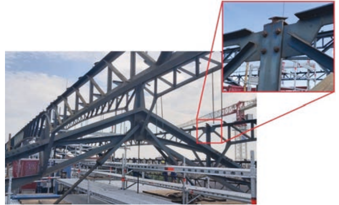
3. ábra: A szelemenbekötés környezete és kialakítása (fotó: FŐMTERV)
