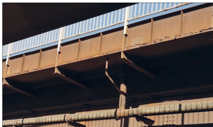
6. kép: Korrózióvédelmi felújítás a sarok környezetében ráfestéssel
