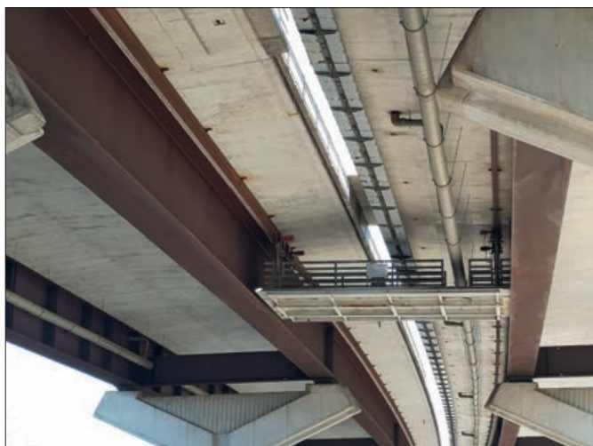
10. kép: Vizsgálókocsi a két híd közötti tér vizsgálatához (felette lefedett légrés)
