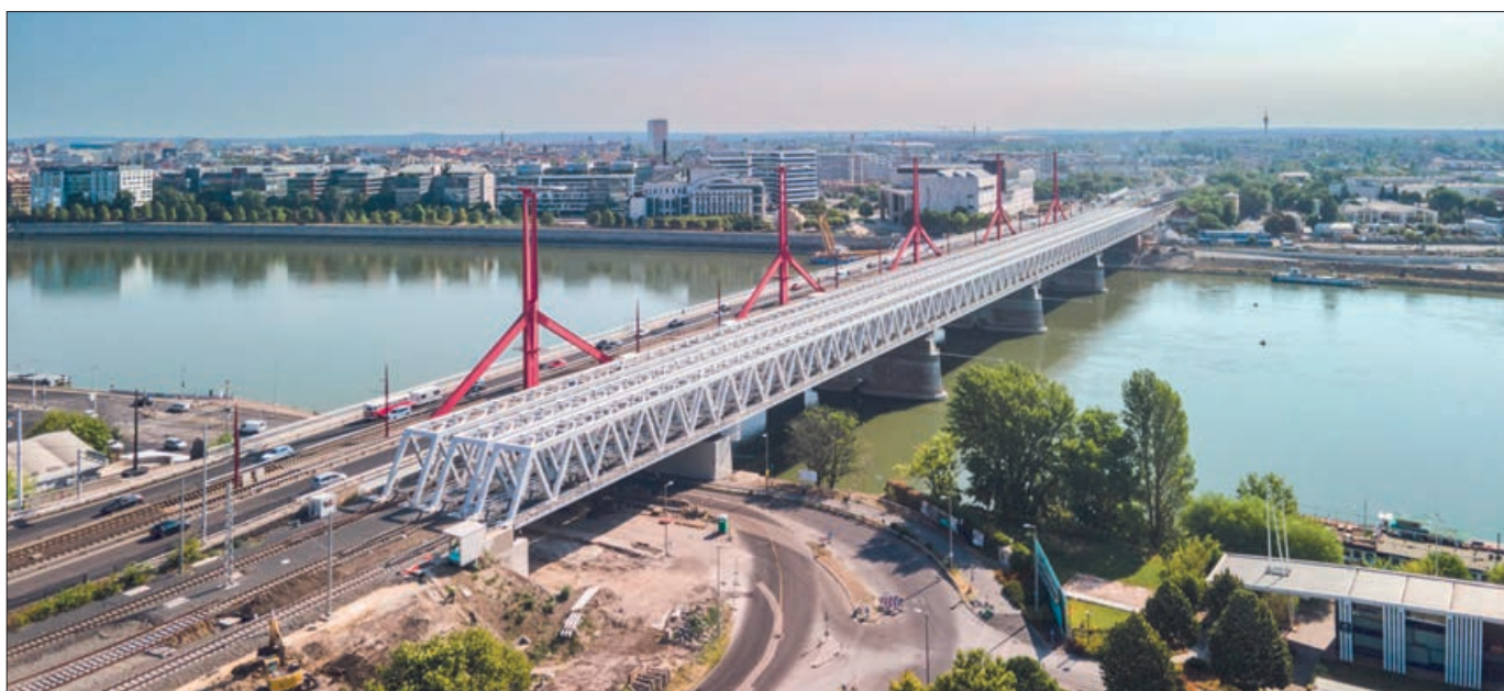
6. ábra: A 2020–2022 között átépített új Déli összekötő vasúti híd (fotó: MÁV)
