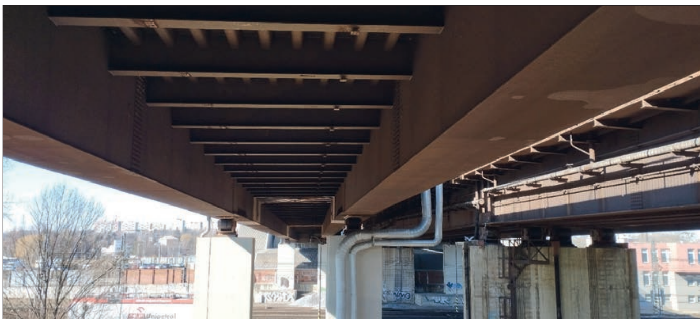
5. kép: Acél zárt szelvényű hosszartók – Vasút feletti híd I.
