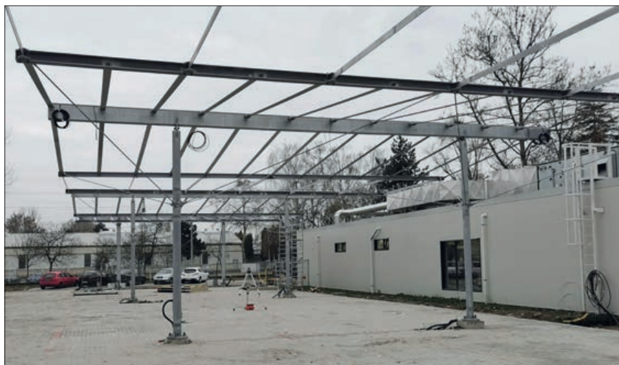
12. kép: KÉSZ Greentech Solar Parking építése
