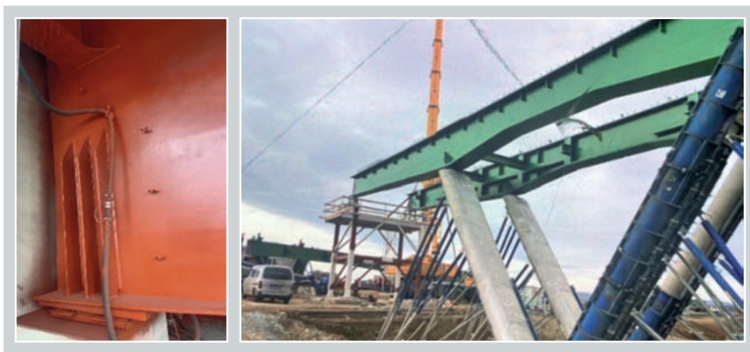
3. ábra: Részleges magasságú merevítőborda alkalmazása a hídépítésben
