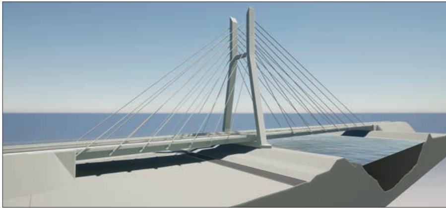
2. ábra: „H” alakú, egypilonos, ferde kábeles híd
