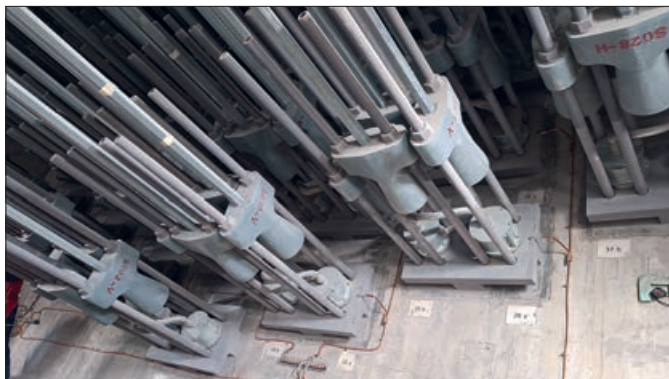
6. ábra: Az előregyártott pászmák leforgonyzása a felső leforgonyzó teremben
