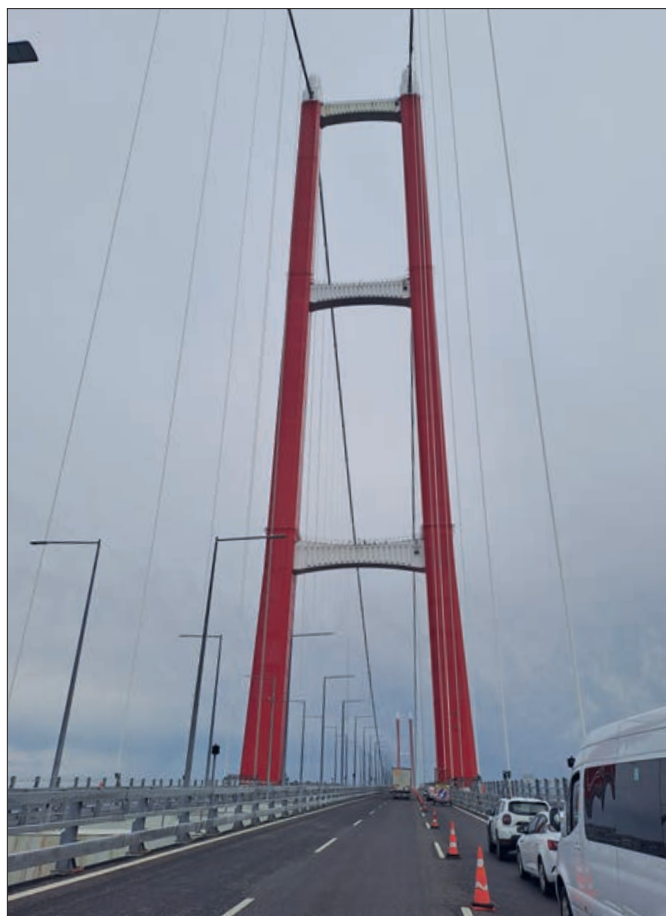
10. ábra: A híd kocspályája a 334 m magas pylonkapuzattal
