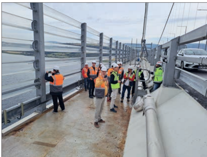
13. ábra: A függőhíd széles kezelőjárdája és a merevítőtartóba vezető bűvónyílás
