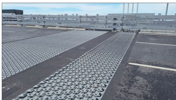
12. ábra: A függőhíd végén lévő dilatációs szerkezet az Ázsia felőli csatlakozó parti hídrész dilatációjával
