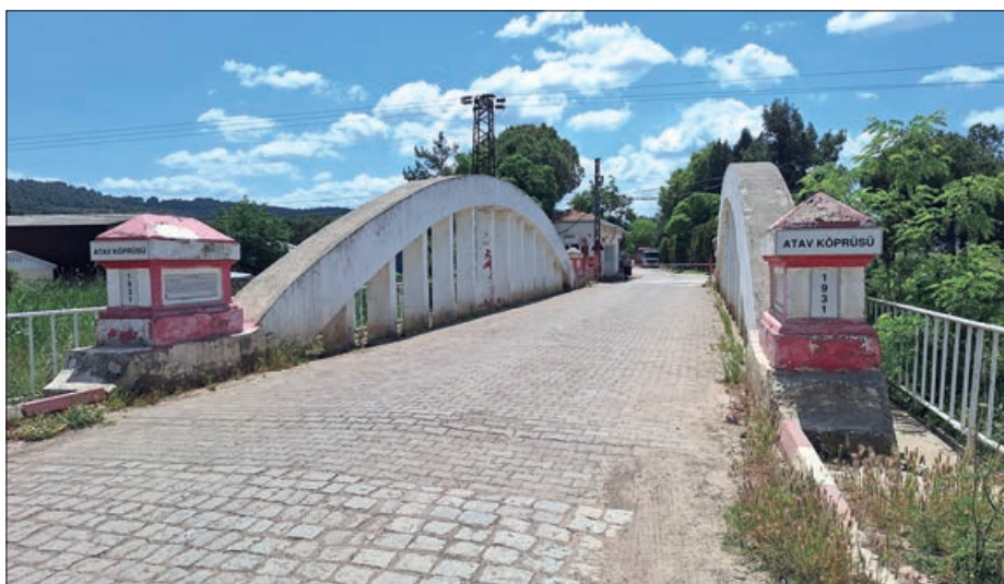
27. ábra: Egynyílású alsópályás vasbeton műemlék török hídszerkezet Çan városában
