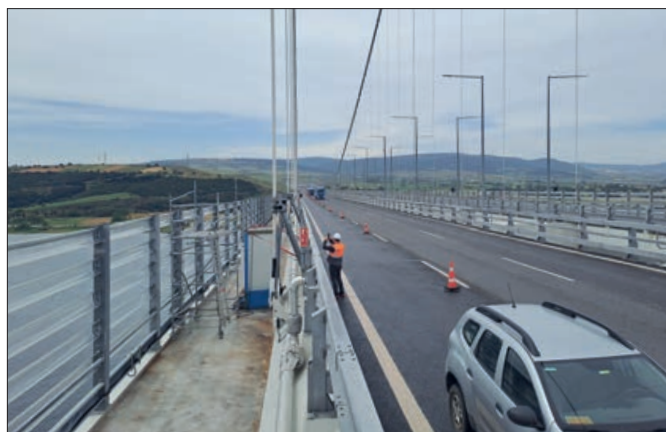
11. ábra: A merevítőtartó a szélvédő fallal és a beépített tűzoltórendszerrel
