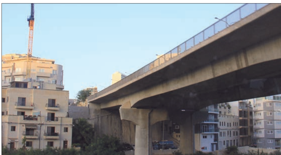
6. kép: Mannel Dimech Bridge
