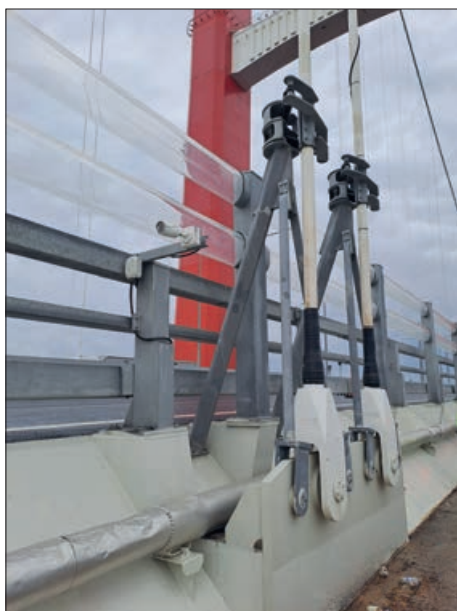
17. ábra: Pilonszáraknál lévő kettős függesztőkábel és azok lengéscsillapítója
