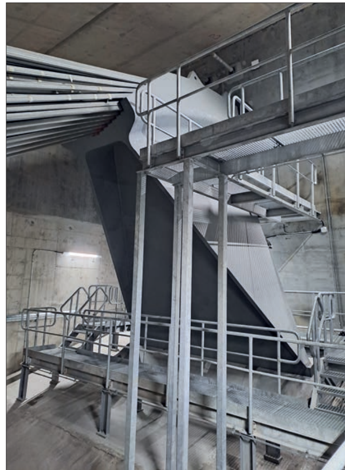
8. ábra: A felső leforgonyzóteremben lévő iránytörő ingasaru
