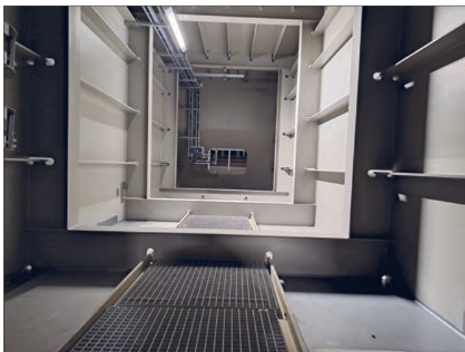
16. ábra: Az ikerszekrény keresztmetszetű merevítőtartó szekrényeit összekötő keresztartó belső nézete
