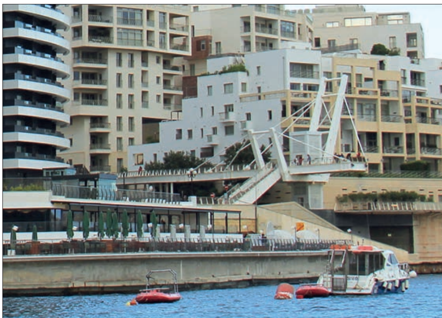
3. kép: Sliema, Tigné Pedestrian Bridge
