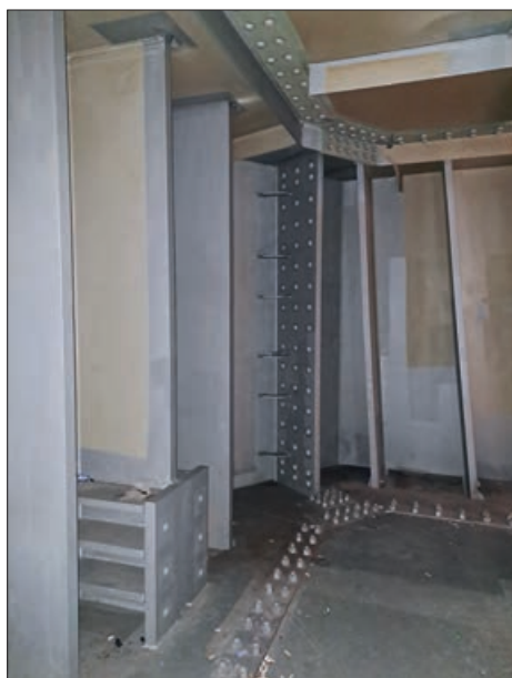
19. ábra A pilonszár acélszerkezetének belső nézete
